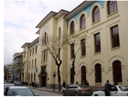
Resim 2.4. Ankara Adliye Binası (Mimarı Tahsin Bey) (Kaynak: Web İletisi 4)
